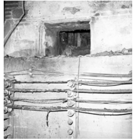
Alcune fasi dell'intervento e i cavi bruciati sotto l'imbocco di una condotta di areazione
