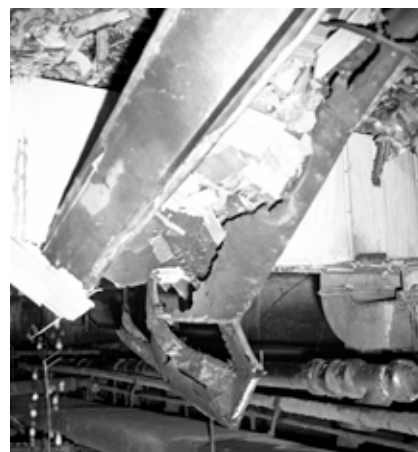
Sopra, la centrale di condizionamento al terzo piano interrato e le condotte di ventilazione bruciate e crollate. A sinistra, il deposito dei bagagli
