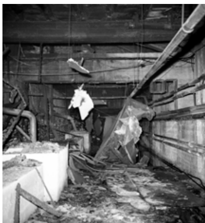
Sopra, la centrale di condizionamento al terzo piano interrato e le condotte di ventilazione bruciate e crollate. A sinistra, il deposito dei bagagli
