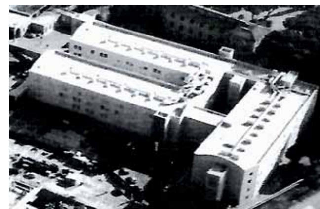
A sinistra, il nuovo edificio della mensa. Dall'alto, la nuova palazzina delle aule e i nuovi dormitori
