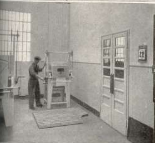
Cementazione e tempera elettrica
