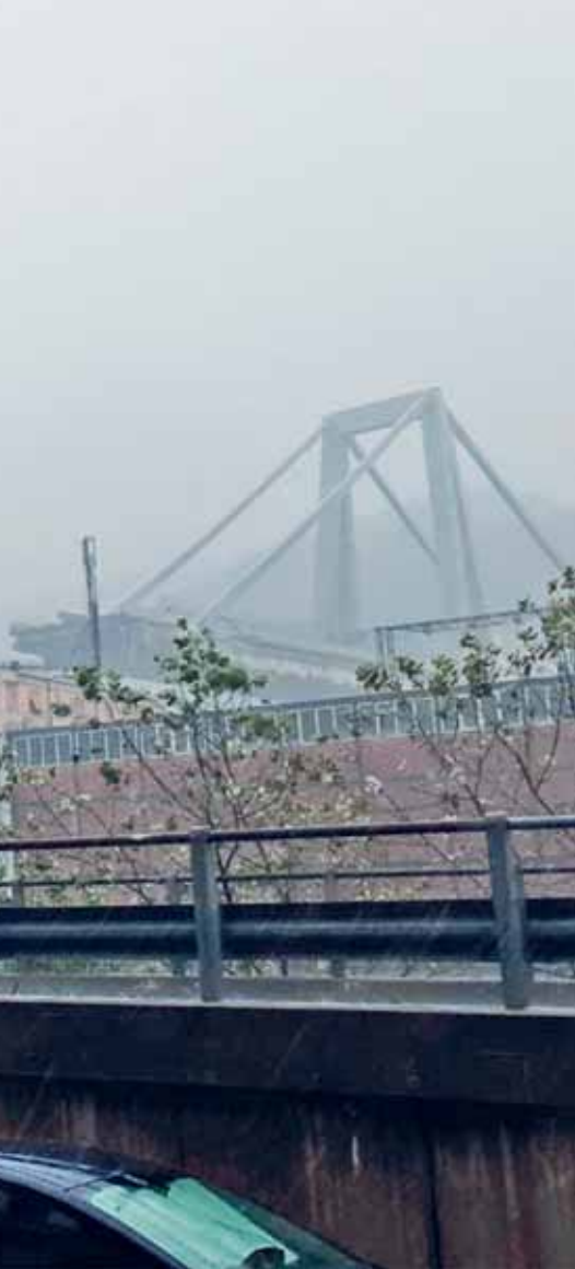
Sopra e in alto a destra, immagini del ponte Morandi subito dopo il crollo. Sotto, squadre di VVF al lavoro in cerca dei superstiti
