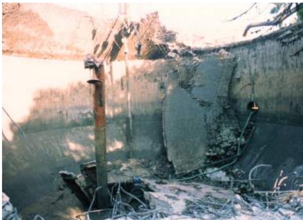
L'interno del digestore dopo l'asportazione di gran parte dei fanghi.
