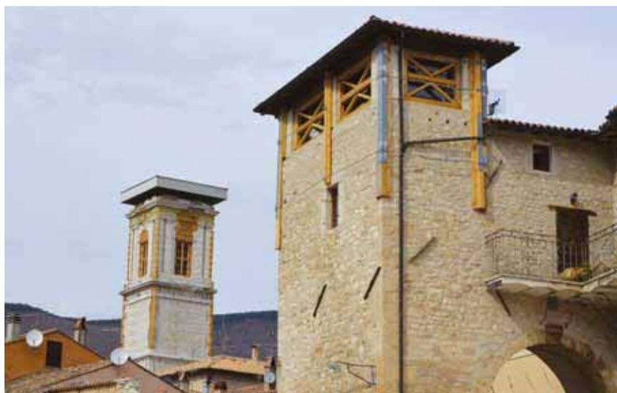
crolli nel portico d'ingresso, nella copertura e nella torre campanaria; sono ancora in corso i lavori di messa in sicurezza con centinaia di archi e tirantature con funi in acciaio e con fasce elastiche sulla torre campanaria e con il rifacimento della copertura leggera dello stesso campanile.
